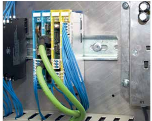
Das kompakte S-DIAS System von Sigmatek steuert den MagicShoe.
