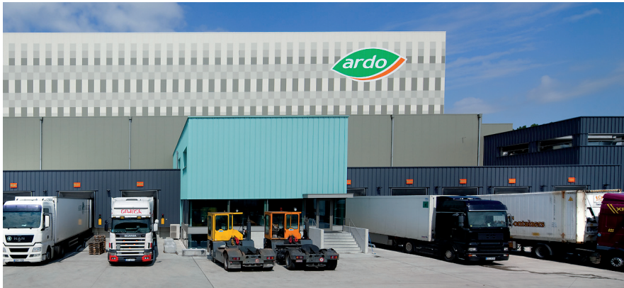
Den größten Teil des Firmengeländes am Stammsitz in Ardoorie nehmen Kühlhäuser und das Logistikzentrum ein.
