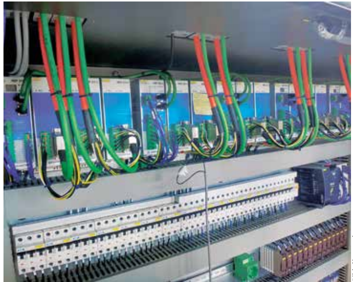
Zur präzisen Steuerung der Servomotoren ist das modulare Multiachs-Servosystem Dias-Drive MDD 100 im Einsatz.
