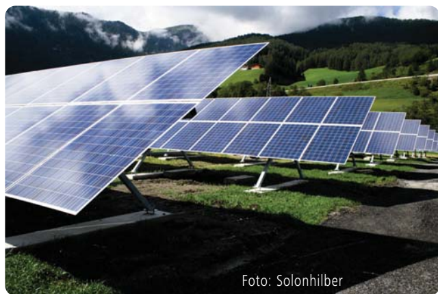
Bild 5: Bei den Solarstromkraftwerken der Solon Hilber Technologie GmbH werden die Solarmodule dem Sonnenstand nachgeführt und erreichen dadurch, je nach Nachführungstechnologie, einen Energiemehrertrag von 22 bis 38% gegenüber fix installierten Anlagen.
