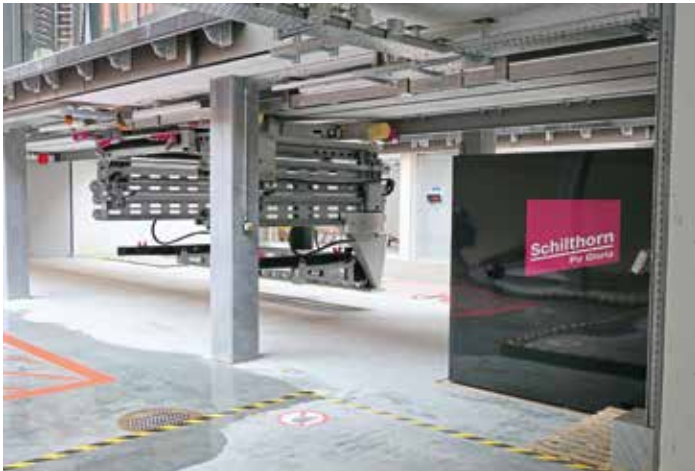
Der Andockprozess eines Containers an die Seilbahn-Kabine.
