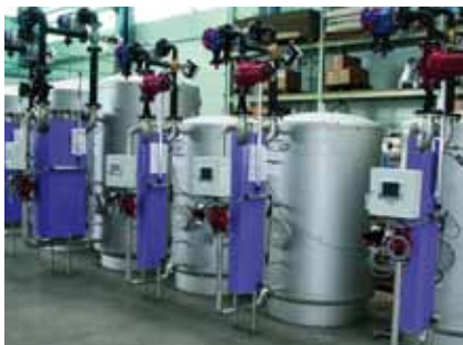
Die Wärmetauscher für die Warmwasser- erzeugung sind besonders energieeffizient. Steuerung und Visualisierung erfolgt mittels Control Panels HZS 555 mit 5,7" VGA TFT- LCD-Farbtouchscreen und EDGE-Technology von Sigmatek.
